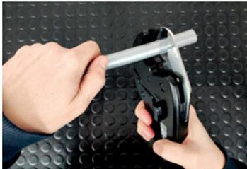
1. Отрезать нужную длину трубы PEX-A с помощью ножниц. Разрез должен быть перпендикулярным оси трубы. Лезвия ножниц должны быть острыми и без зазубрин.
